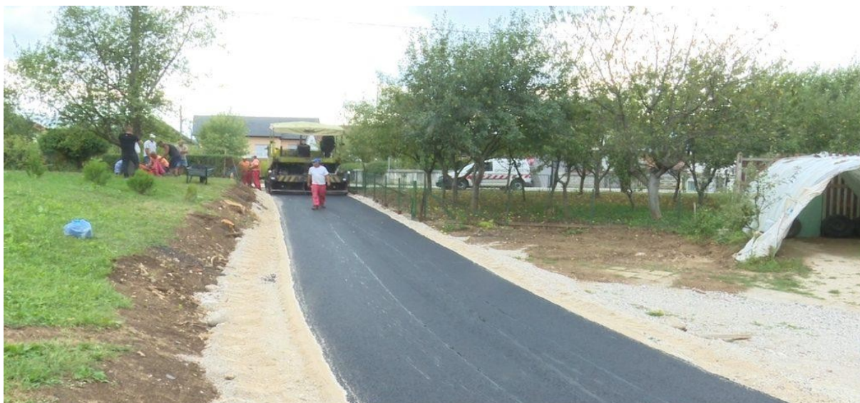
Radovi na asfaltiranju puta u MZ Vrhpolje, zaseok Kerići-Hukanovići
