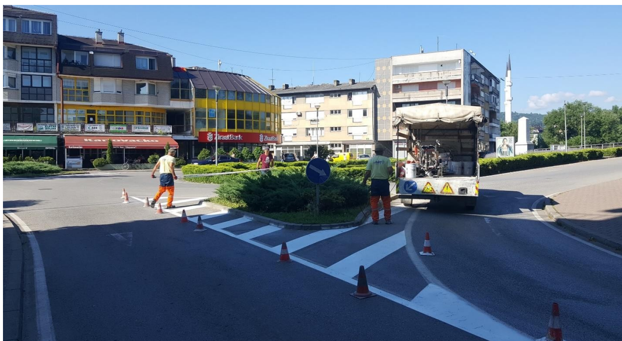
Izvođenje radova na izradi horizontalne signalizacije
