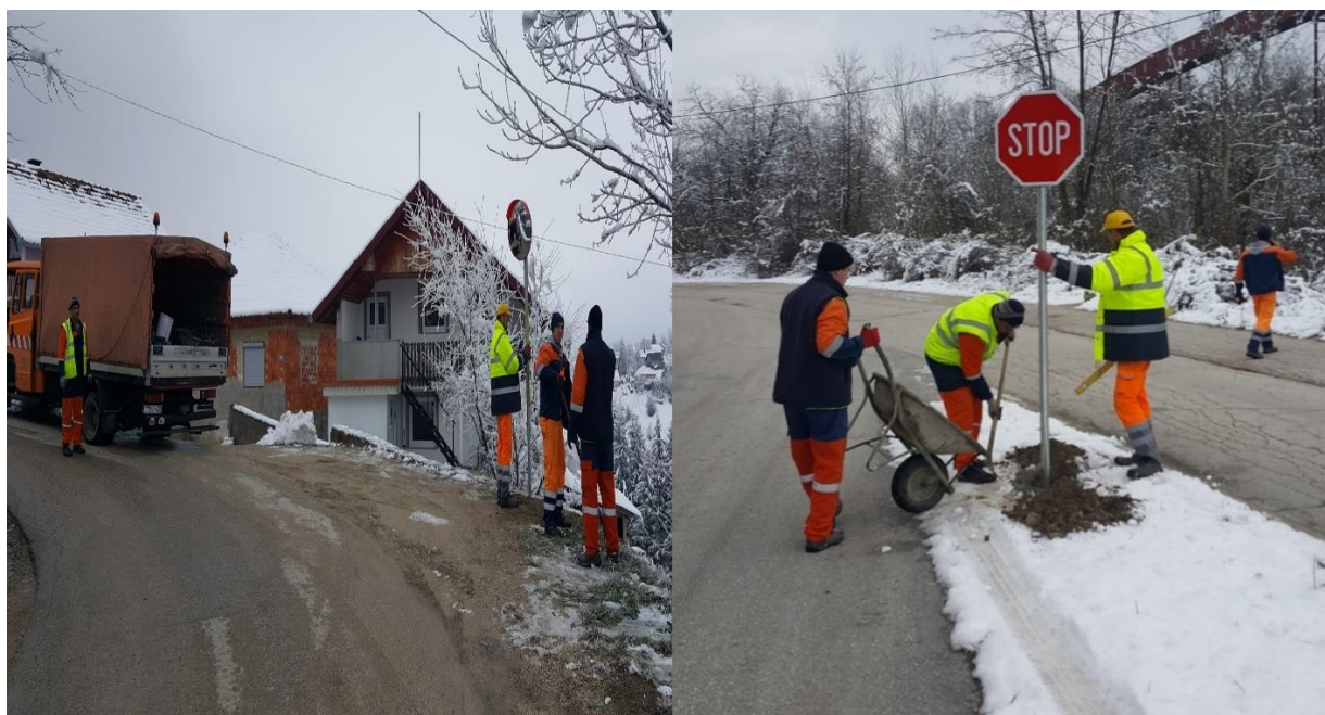
Izvođenje radova na postavljanju vertikalne signalizacije i saobraćajnog ogledala
