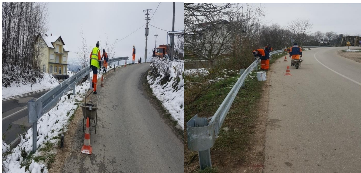
Izvođenje radova na postavljanju saobraćajne opreme ceste (zaštitna ograda)
